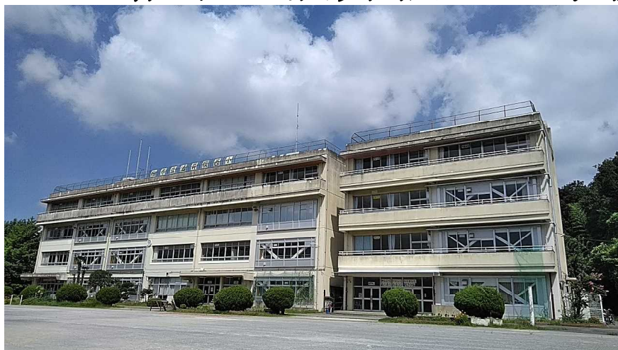
↑校庭側から見た A 校舎 (令和 3 年度外壁工事予定)
