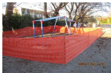
【現在、土台の工事中】
